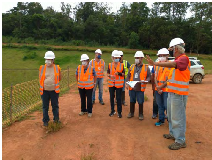
Foto 4 – Visita ao canteiro de obras Data: 11/03/2022
