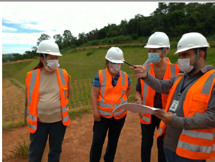
Foto 3 – Visita ao canteiro de obras Data: 11/03/2022
